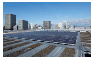
日本生命本店（東館）屋上
