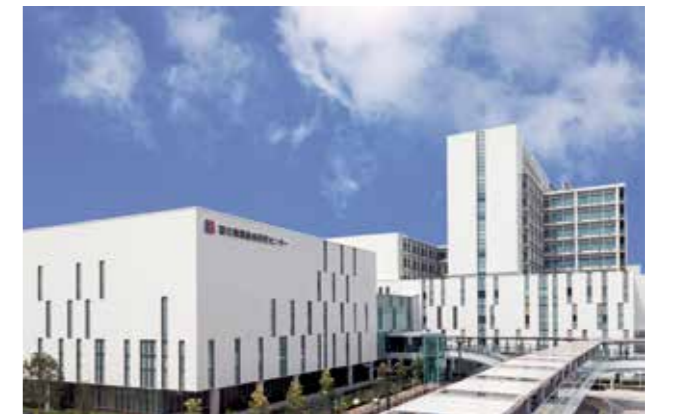
オープンイノベーションセンター(大阪府吹田市岸部新町)
