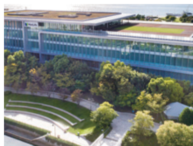
長崎本社 長崎県長崎市 メットライフ生命長崎ビル
