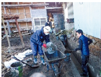
2019年台風19号丸森町土砂撤去
