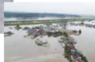
2019年台風15号による被害の様子
